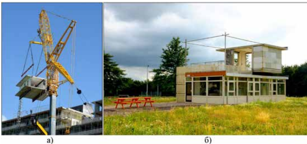
Рис. 1. Використання демонтованих конструкцій для будівництва нових будинків в ході реконструкції соціального житла. Проєкт Super Circular Estate (Нідерланди).
